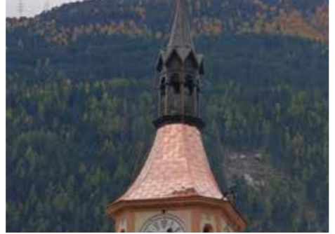
Auf diesem Bild neigen sich die Arbeiten langsam dem Ende zu.
