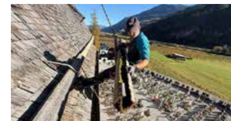
Einer der alten Schneebäume, der sichtlich bereits sehr morsch war und getauscht werden musste.
