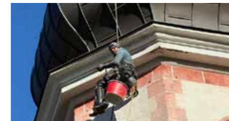
Arbeiten am Gesimse und Kirchturmdach.
